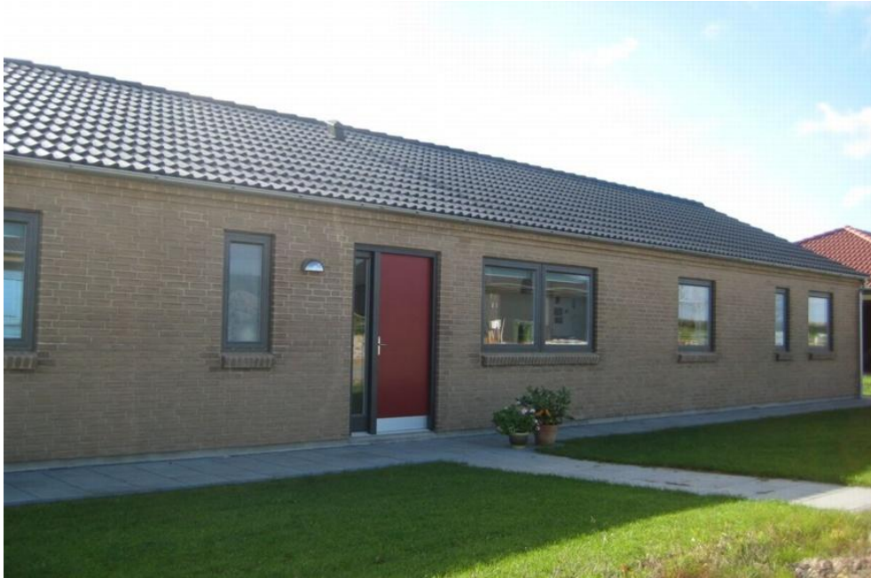
Huset bliver opført i samme stil.
